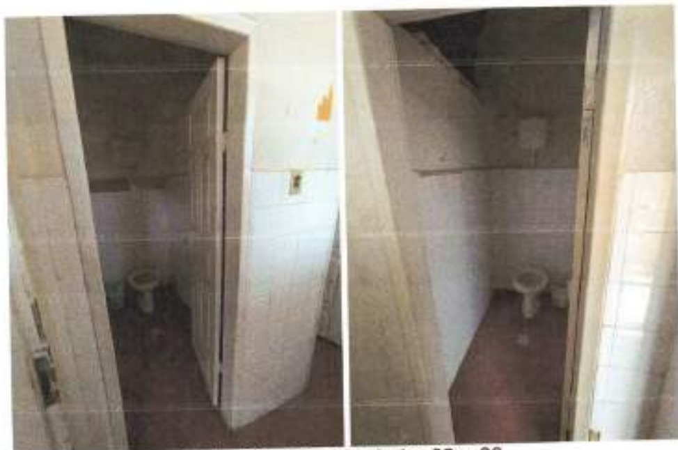
Foto 09 e 10 – Banheiro 02 e 03
