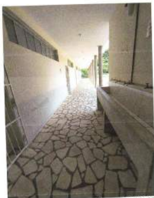
Foto 13 – Corredor de Acesso das sala 06, 07, 08 e 09
