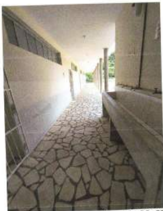
Foto 13 – Corredor de Acesso das sala 06, 07, 08 e 09
