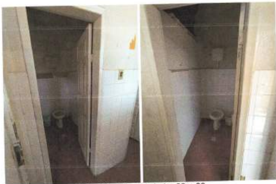
Foto 09 e 10 – Banheiro 02 e 03
