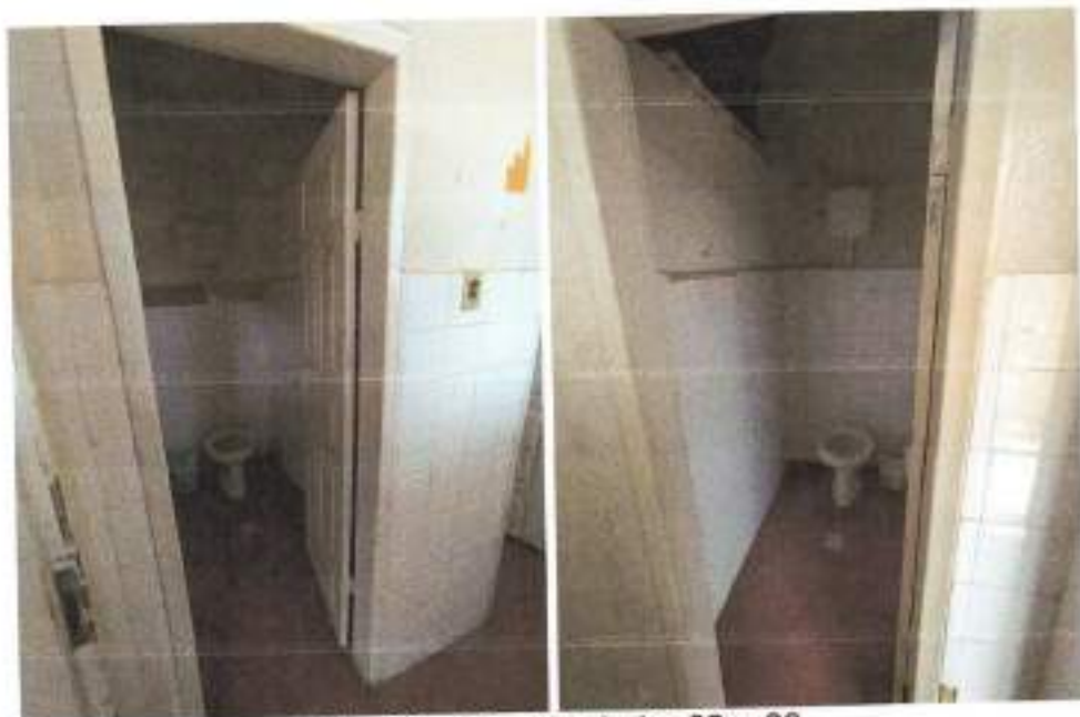
Foto 09 e 10 – Banheiro 02 e 03
