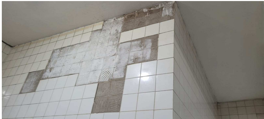
Foto 1: Ex. do local de retirada de revestimento em azuleijo.
