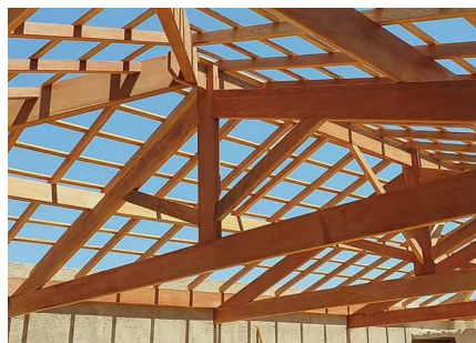
Figura 01: Estrutura em madeira
