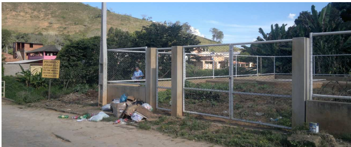
Figura 3: Área da elevatória do Bairro Vila Nova.
