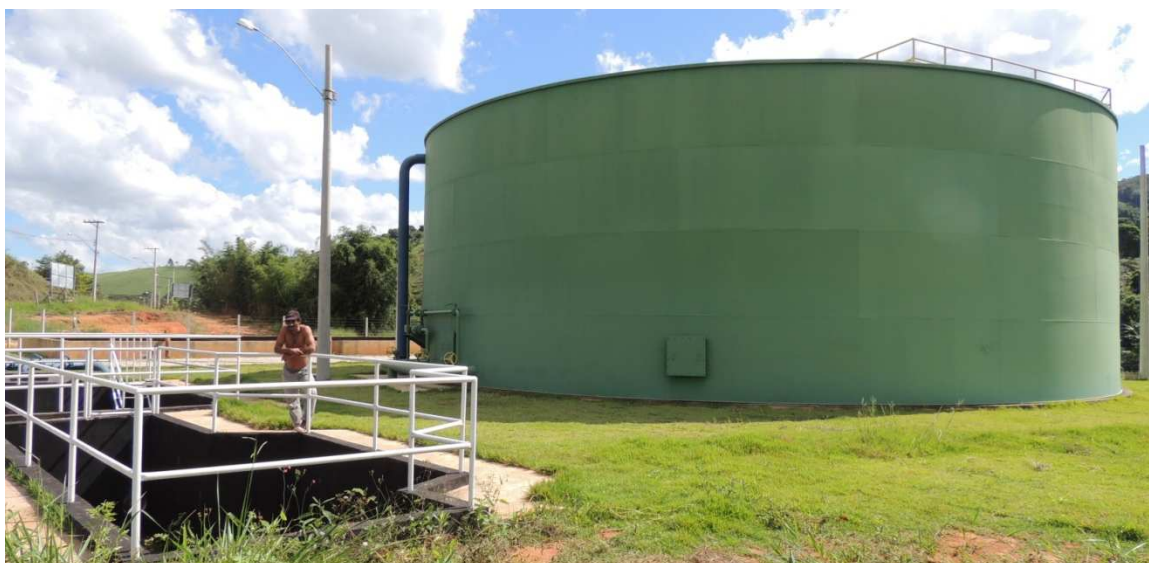
Figura 5: Vista geral da ETE existente.
