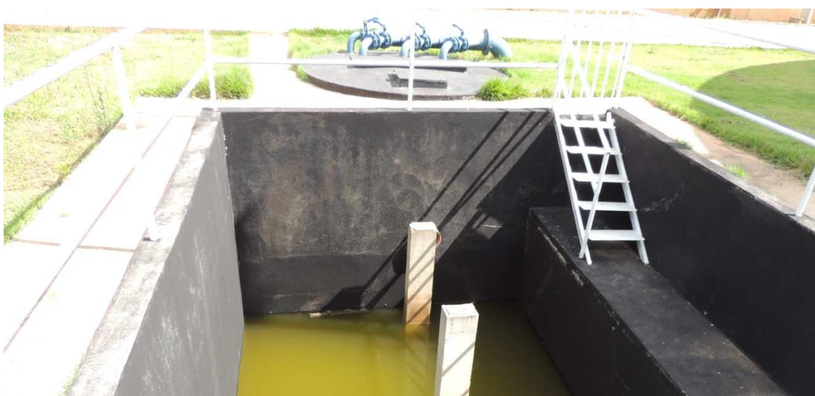
Figura 6: Caixa de entrada e elevatória da ETE.
