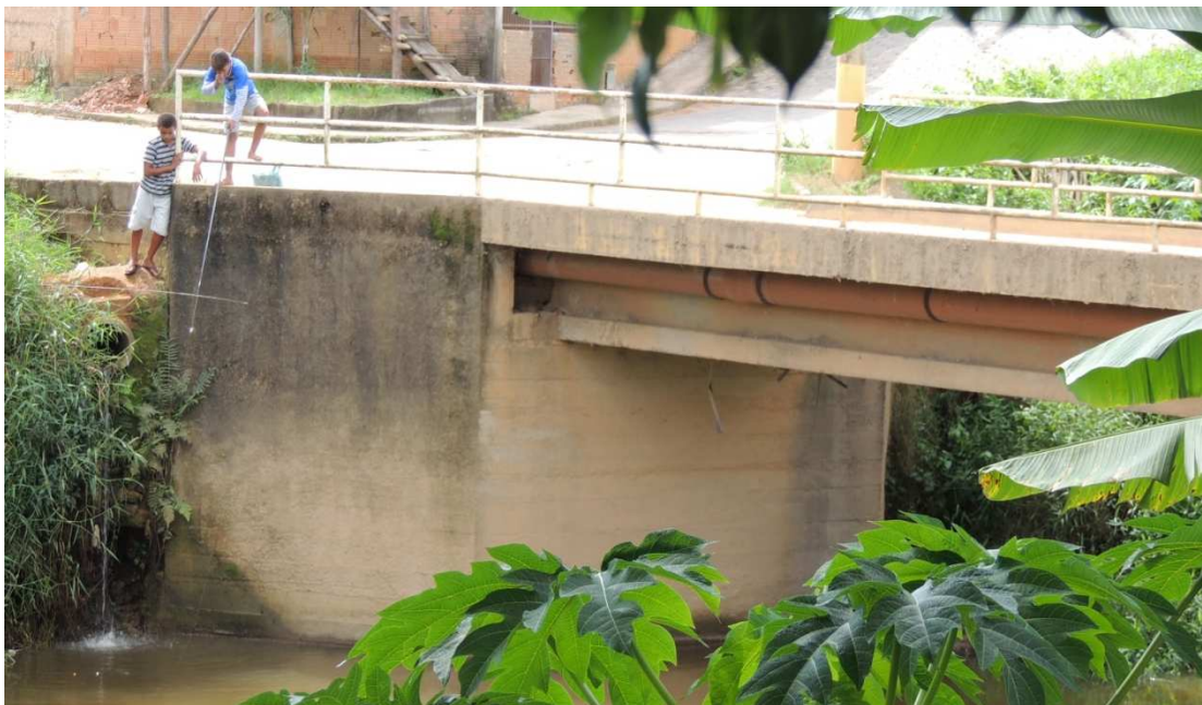
Figura 4: Linha de recalque DN300 que liga a Elevatória localizada no Bairro Vila Nova à ETE.
